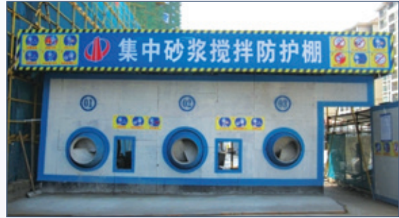
設置防雨、防砸棚
