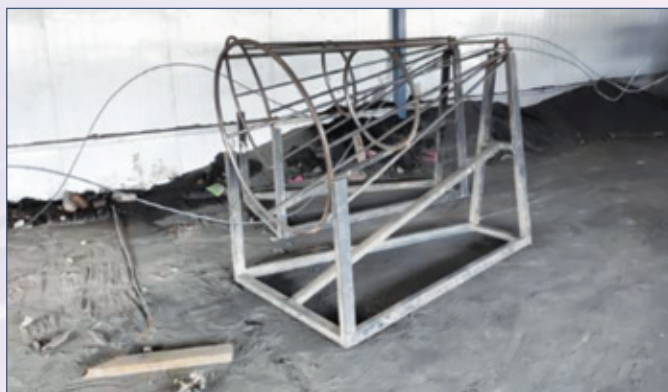
鋼筋調直防護
