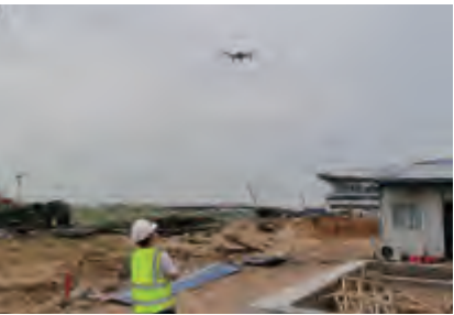
无人机巡查施工现场
