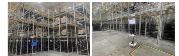
▲ 四向穿梭车 + AGV 机器人存储
