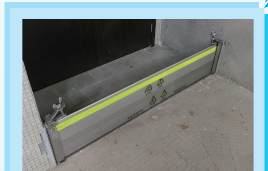
富豪機場酒店的防洪閘
