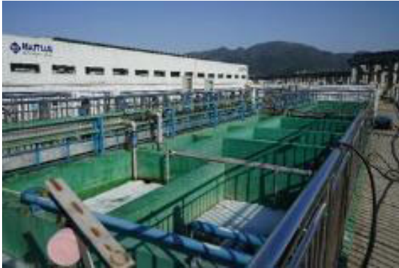
廢水處理站屋頂處理池
