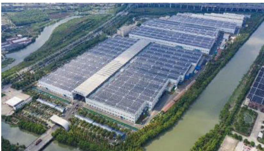
通途路事業部光伏項目
