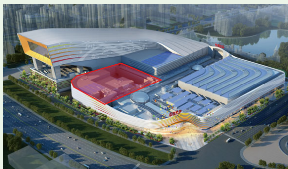
廣州融創茂設置光伏發電系統
