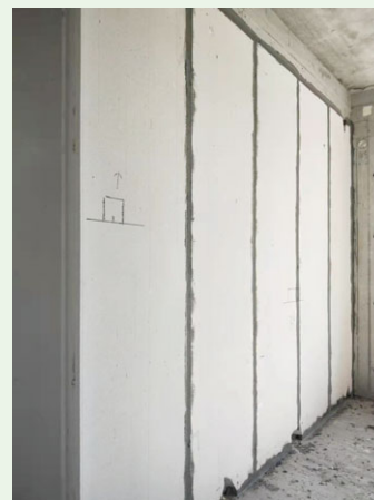
佛山融創半島壹號項目鳥瞰圖及輕質隔牆條板裝配現場實拍
