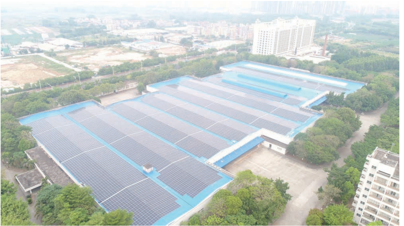
惠州廠房第一期光伏發電設施
