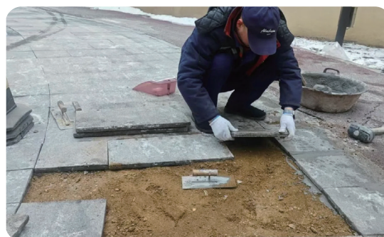
東樾城北小區地面鋪設
