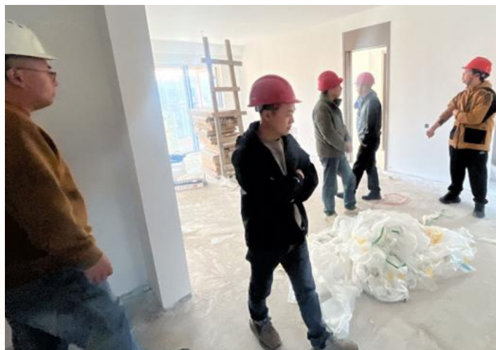
Special inspection 專項檢查
