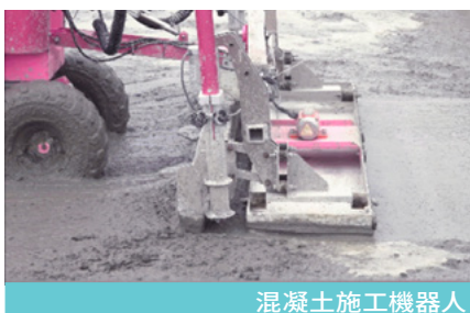
混凝土施工機器人
