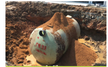
成品隔油池安裝
