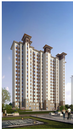
河北邢台隆堯樾江山被動房項目
