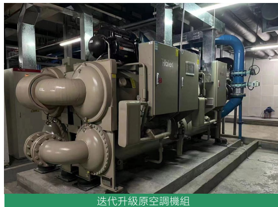
迭代升級原空調機組
