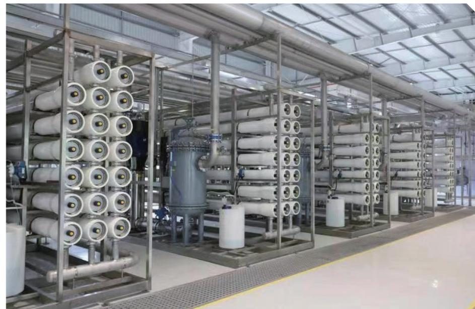
圖13：越南生產基地RO反滲透過濾裝置
