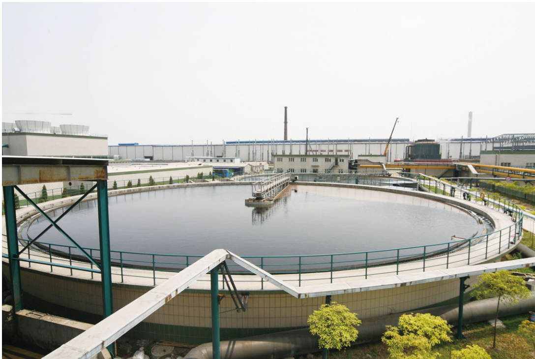
Sewage treatment station 污水處理站
