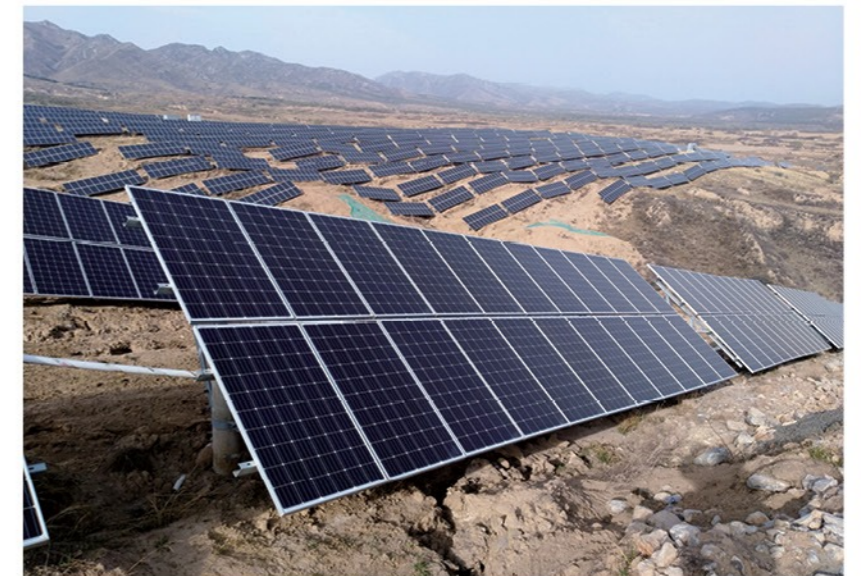
公司承保的山西省太原市陽曲縣、忻州市代縣光伏扶貧電站
