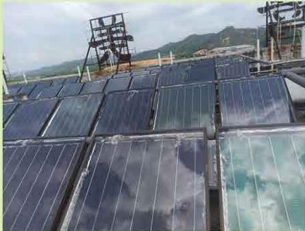
宜豐廠採用太陽能熱水設備，每年節省約50,000千瓦時的市政用電。
