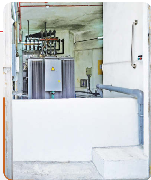
● 在變電站加設水閘
