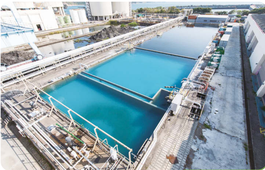
● 南丫發電廠的雨水和可再用廢水蓄水坑
