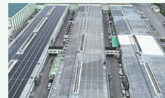
河南安井光伏項目
