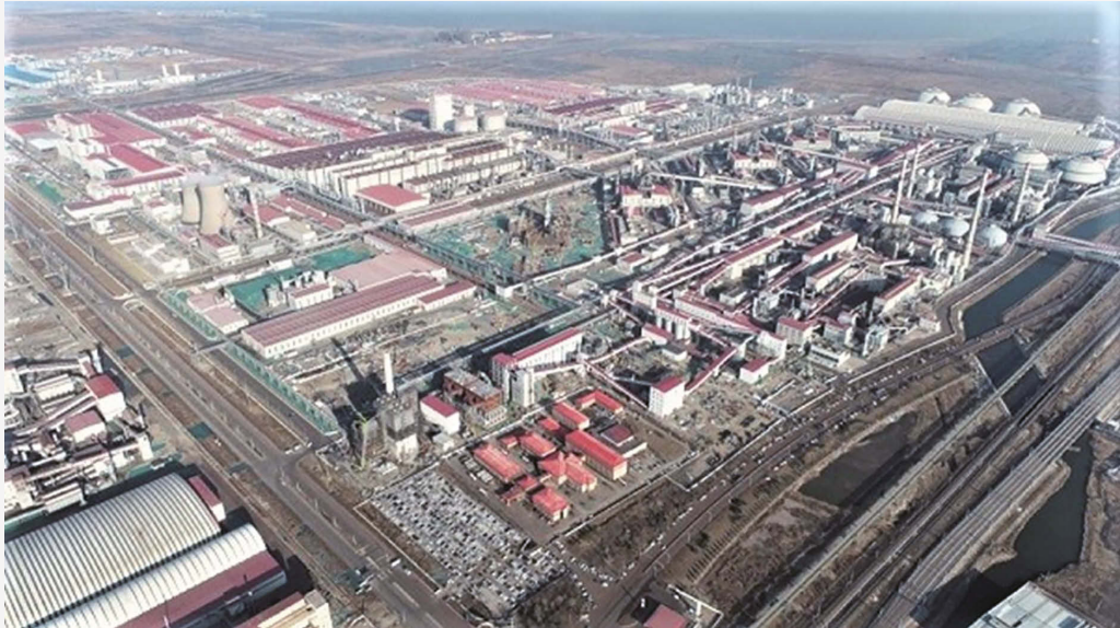
中信金融資產河北分公司實施某鋼鐵企業拆廢實質性重組項目現場
