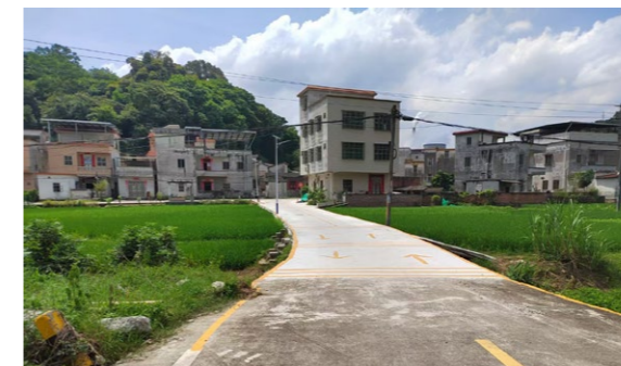
雲浮市八和村鄉村路段硬底化改造
