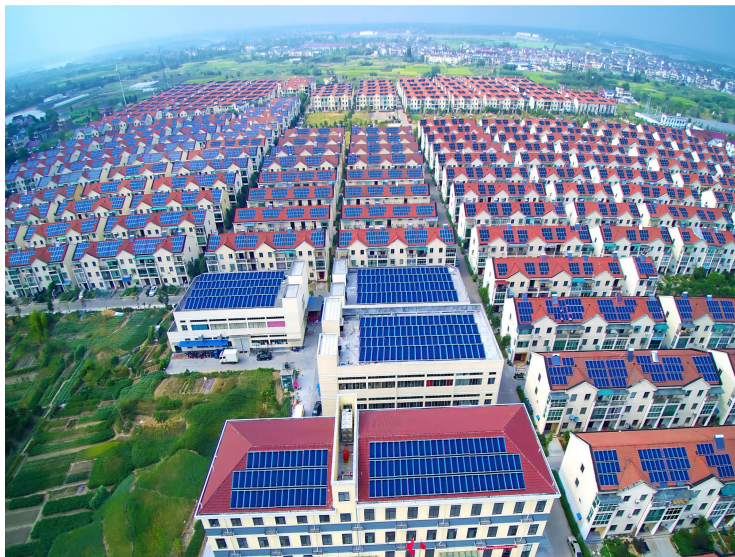
圖注：正泰安能分佈式光伏電站項目
