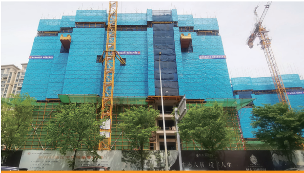
施工外圍安全設施
