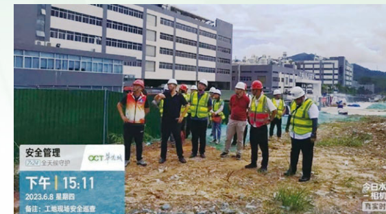
雙創產業園工地安全巡查
