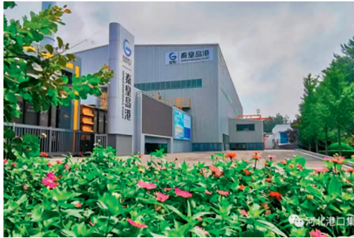
秦港煤三期翻車機房外景
