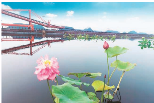
礦石堆場儲水沉澱池
