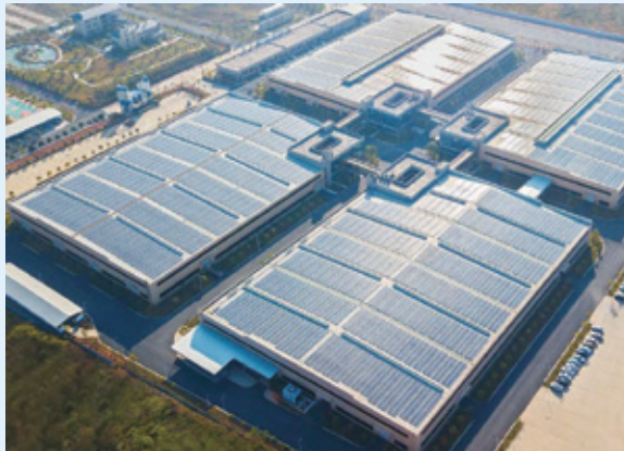
威勝電氣有限公司生產基地部分廠房
