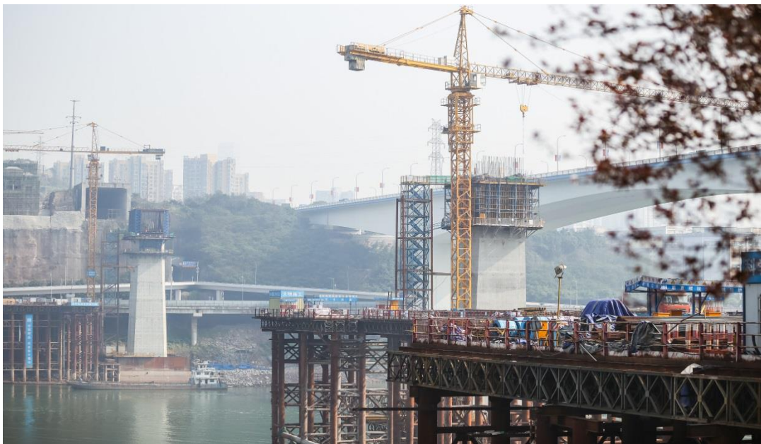
重慶軌道九號綫施工現場
