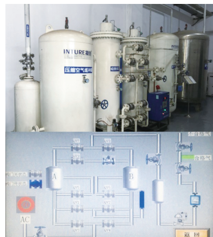
原料藥廠區制氮機進氣單元自動控制節能改造， 一期系統每年節約電費9萬元
