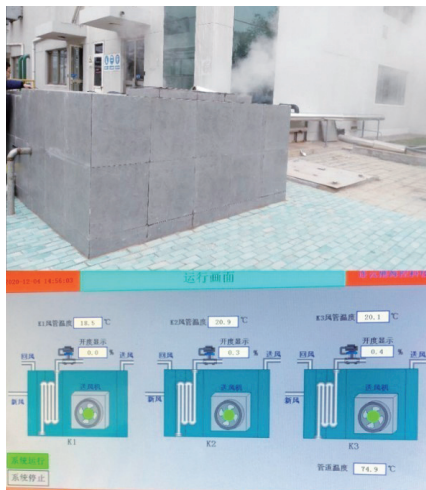
201車間蒸氣冷凝水餘熱回收利用， 每年節省蒸氣費用近12萬元
