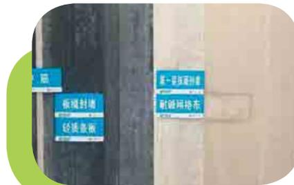
內牆工法：採用蒸壓陶粒混凝土輕質條板隔牆，有效控制空鼓裂縫。
