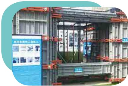
鋁模工法：11道工序，實現牆柱垂直度偏差和頂板水平極差都精準控制在5mm以內。
