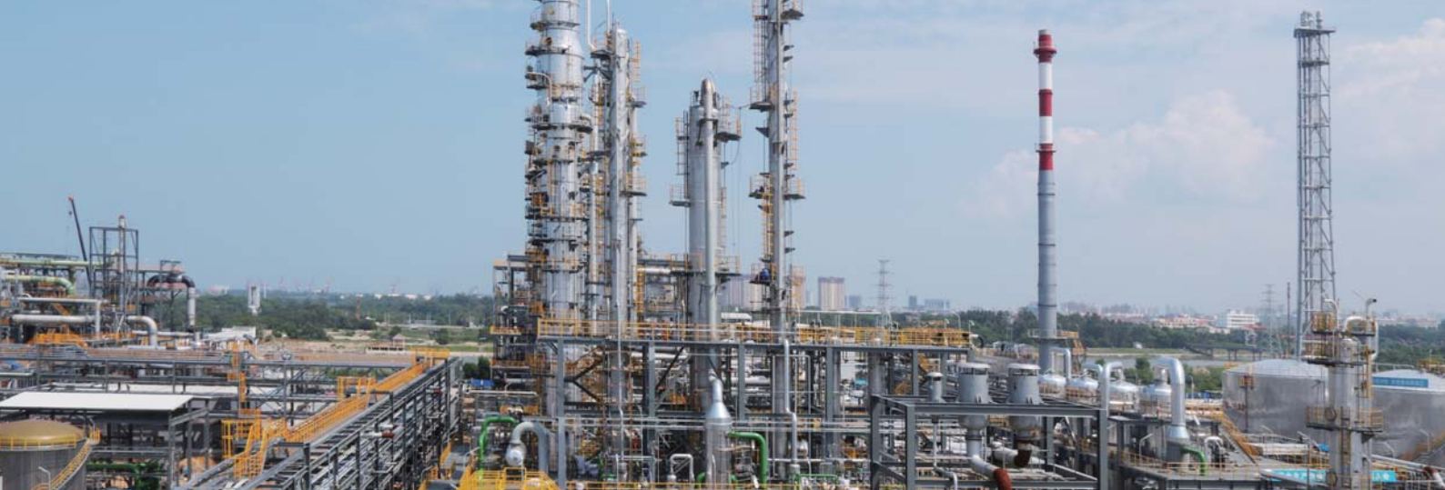
■ 丙烯腈裝置局部
