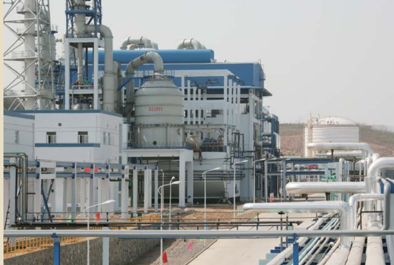
■ 大峪口化工二期磷酸裝置
