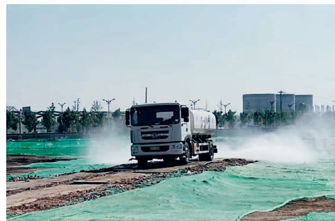
土方覆蓋灑水降塵
