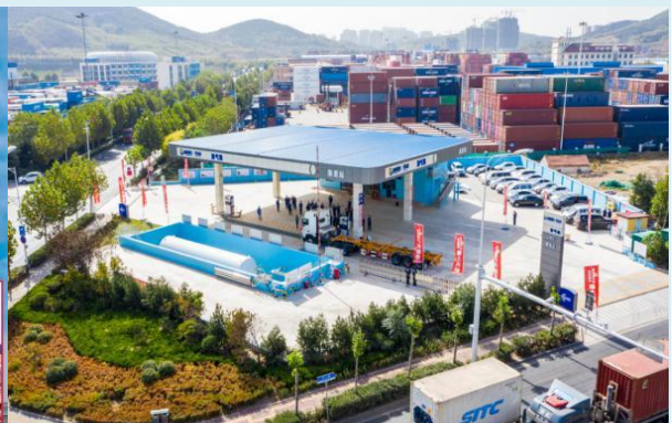
前湾南港区新建 LNG 加气站
