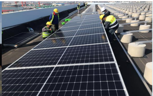
冷库库顶安装光伏发电设施
