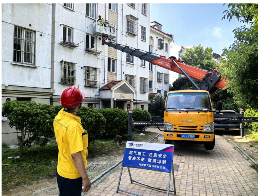
老舊小區管網改造施工中
