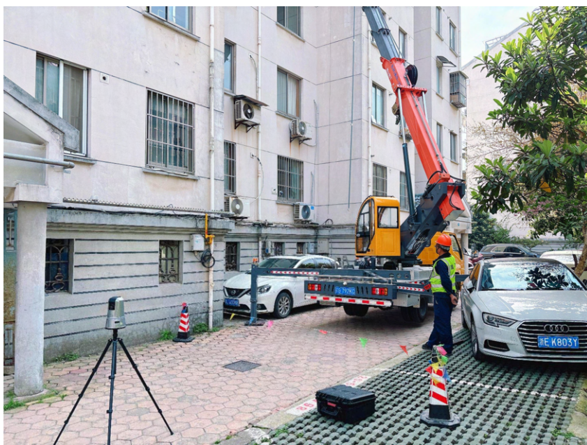
由球機拍攝直播施工
