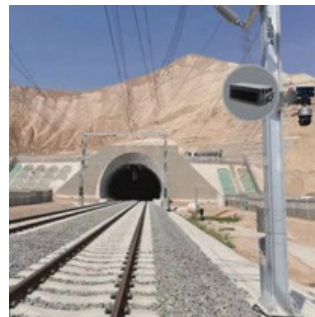
安裝在列車軌道上方
