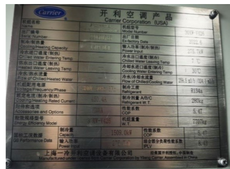
空調冷凍水製螺桿機組
