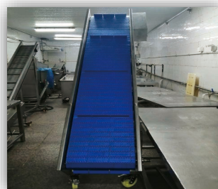
The hoist installed 提升機已安裝完成
