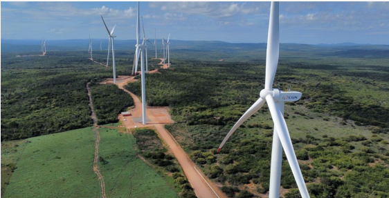
清洁能源项目现场
