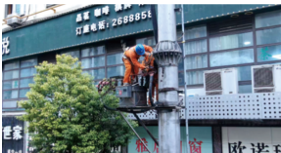
船山公司人员进行设备检修
