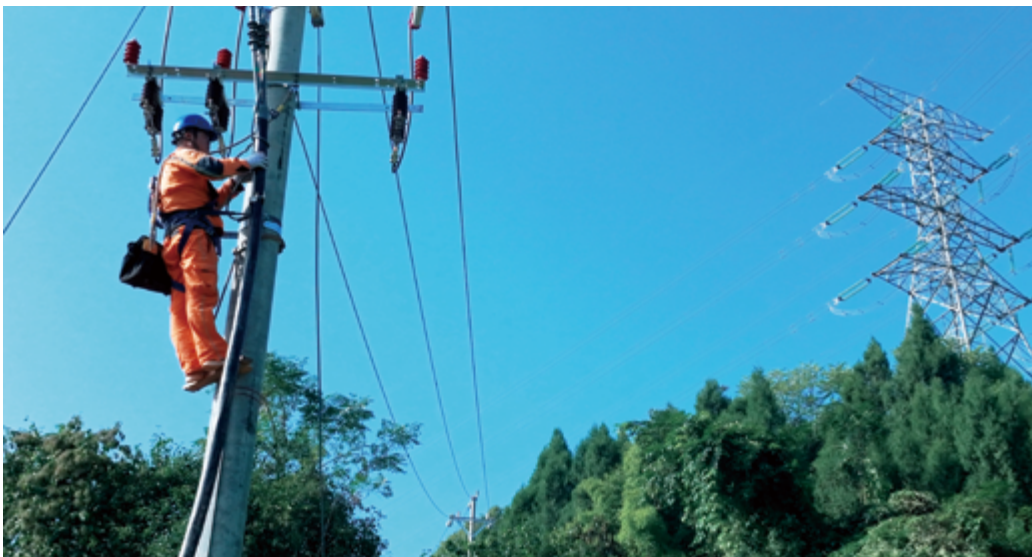
公司抓紧抢修维护电力设施设备
