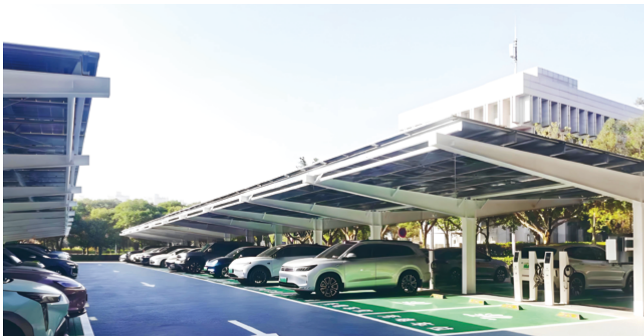
建设充电基础设施
