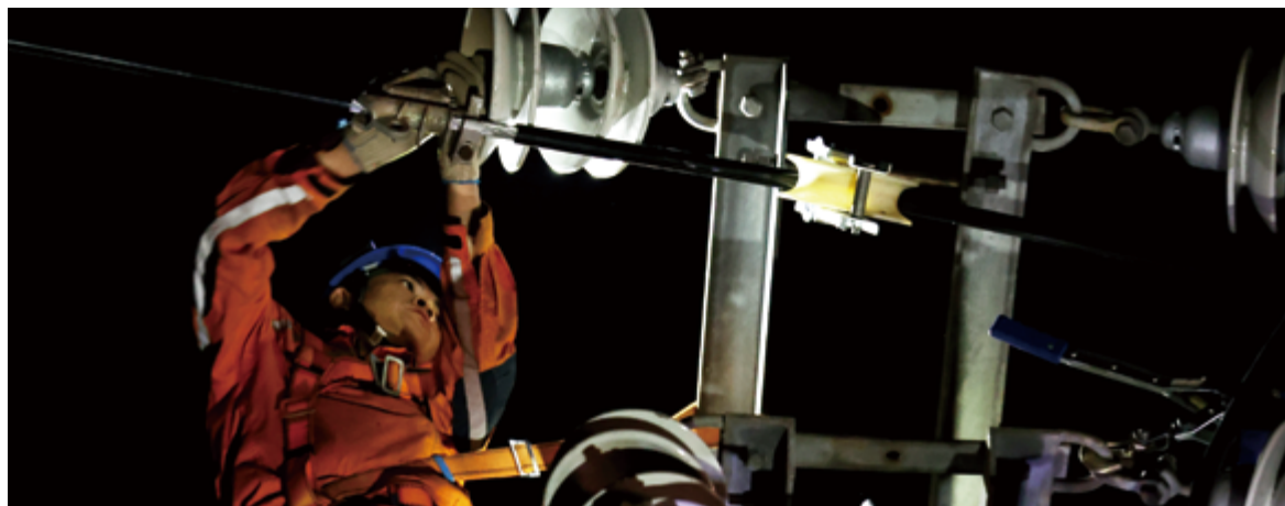
电力工人在抢修现场连续奋战
