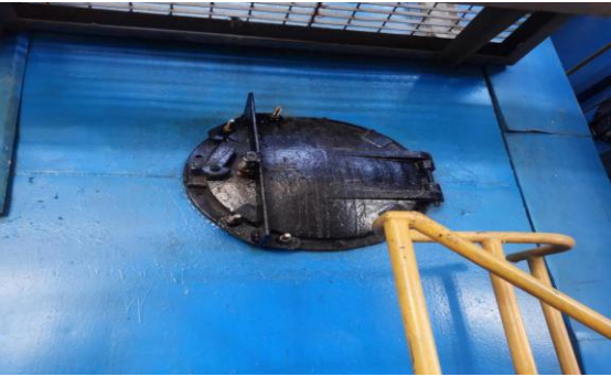
锅炉炉门改造后(螺栓式)
