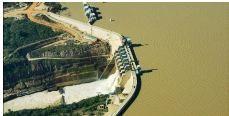
由东方电气建设的坦桑尼亚最大水电站：朱利诺水电站
