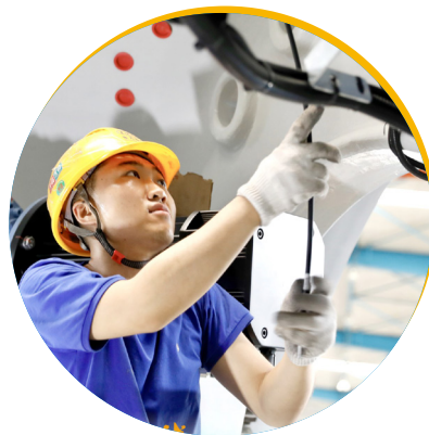
东方风电天津 基地主机制造 职工正在安装 变桨轴承润滑 系统
