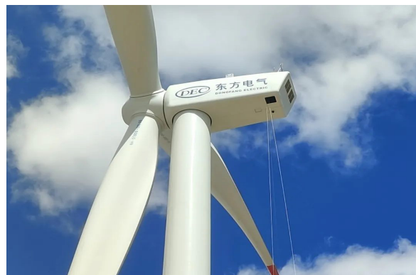
东方风电在西北服务中心组织开展风机机舱高空逃生应急演练
