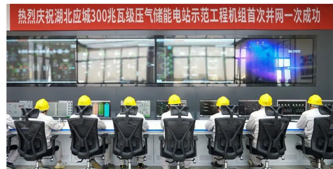
湖北应城300兆瓦级压气储能电站示范工程首次并网一次成功
