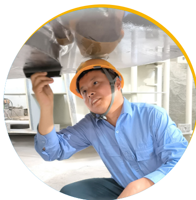
东方电机发电 机安装工程 师在吉尔吉斯 斯坦乌奇库尔 干项目现场检 查转子下法 兰面
