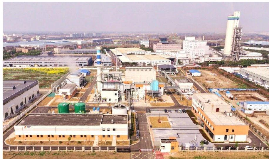
2024年3月16日，东方电气G50燃气轮机在四川德阳经开区分布式能源站通过“72+24”小时运行考核，正式投入商运。
