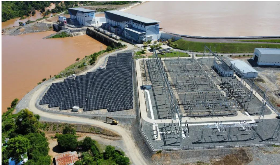
2024年7月1日，由东方电气研制供货的东萨宏水电站扩机项目——5号机组成功投运。
