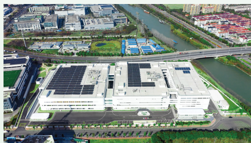
光伏发电系统
